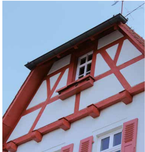
Mauerseglerkasten am Forsthaus
