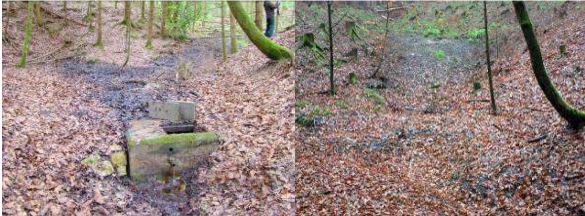
Abbildung 11: Fassungsrückbau in der Abt. „Brünnelschlag“; links: vor der Maßnahme; rechts: natürlicher Quellaustritt nach Rückbau (Bilder: Reichert)
