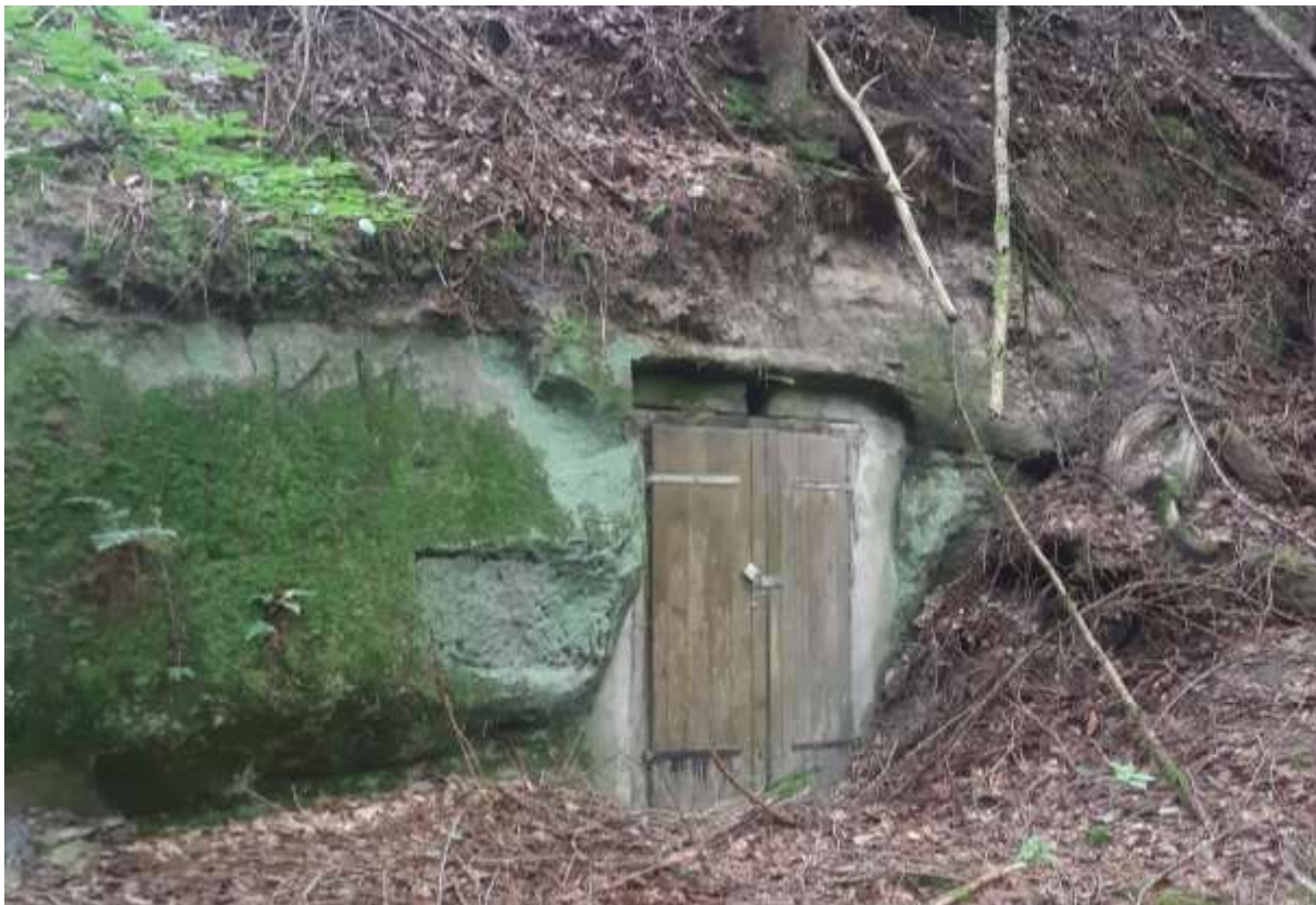
Abbildung 50: ehemaliger Vorratskeller in Abt. Fuchsberg der noch für Fledermäuse zugänglich gemacht werden kann, Rev. Mistelgau (Bild: A. Reichert)
