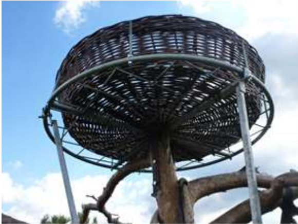
Abbildung 40: Kunsthorst-Unterkonstruktion (Bild: S. Bäumlner)
